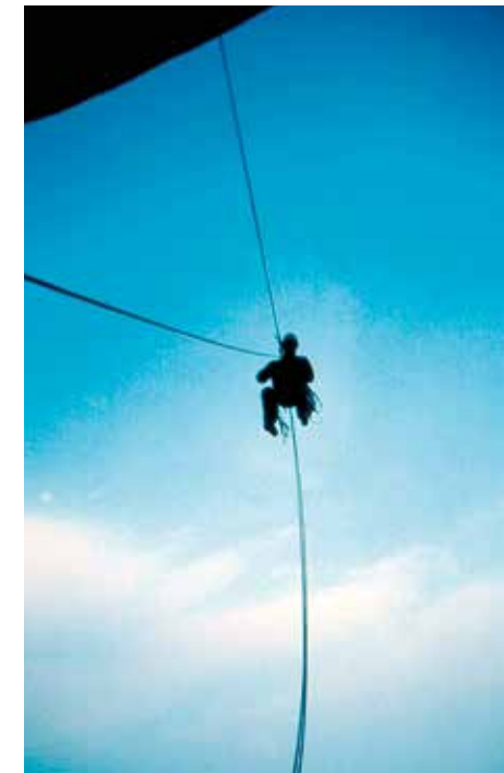
Andrea rientra dal tetto centrale (foto archivio Furlani).
