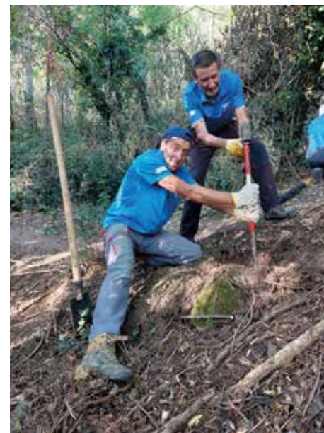
Scavo nel terreno per posa palo.
