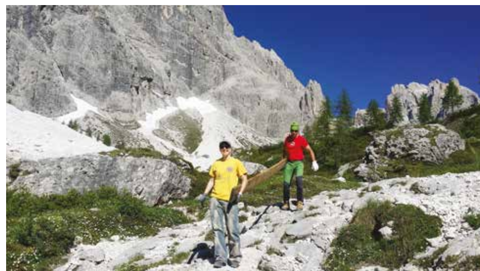
Volontari al lavoro per ripristinare il sentiero che porta al Rifugio Berti al Popera.
